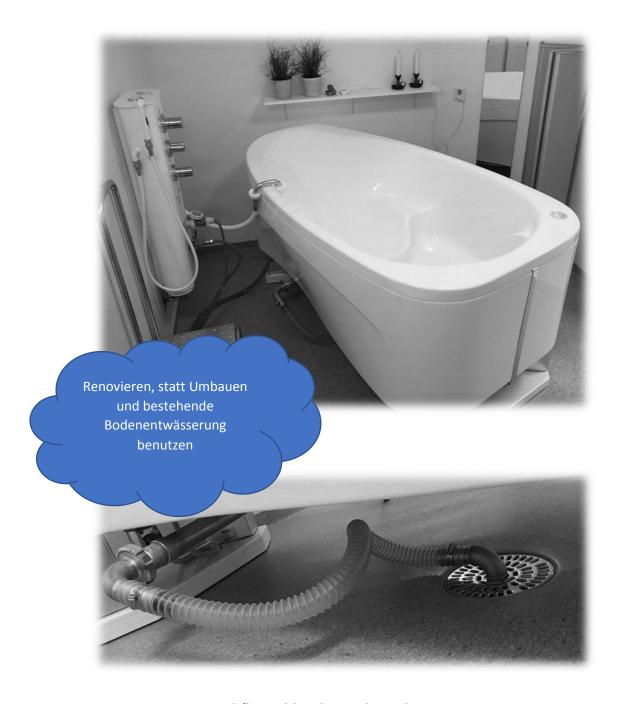
Den Abflussschlauch von der Gebärwanne direkt an den Bodenablauf anschließen
